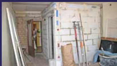
Es werden Tapeten entfernt, Mauern abgerissen, um ein neues barrierefreies Bad einzurichten
